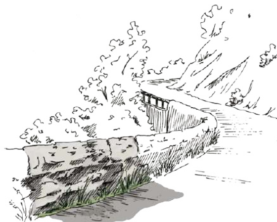
Parapet en pierre dans la Drôme
