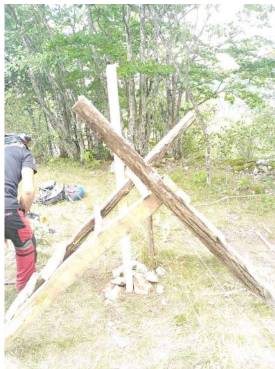
Construction d'échelle de franchissement de parc
