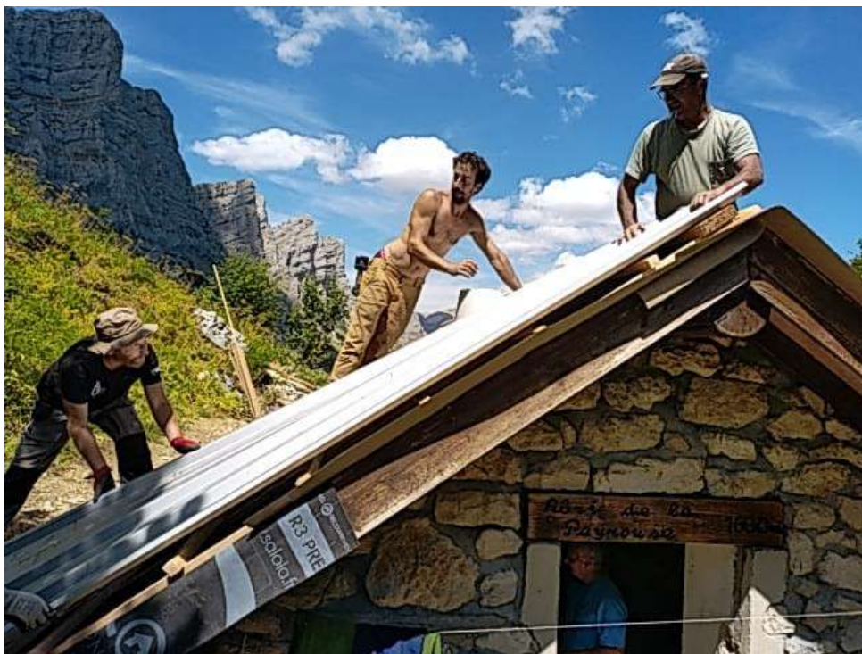
Rénovation du toit
